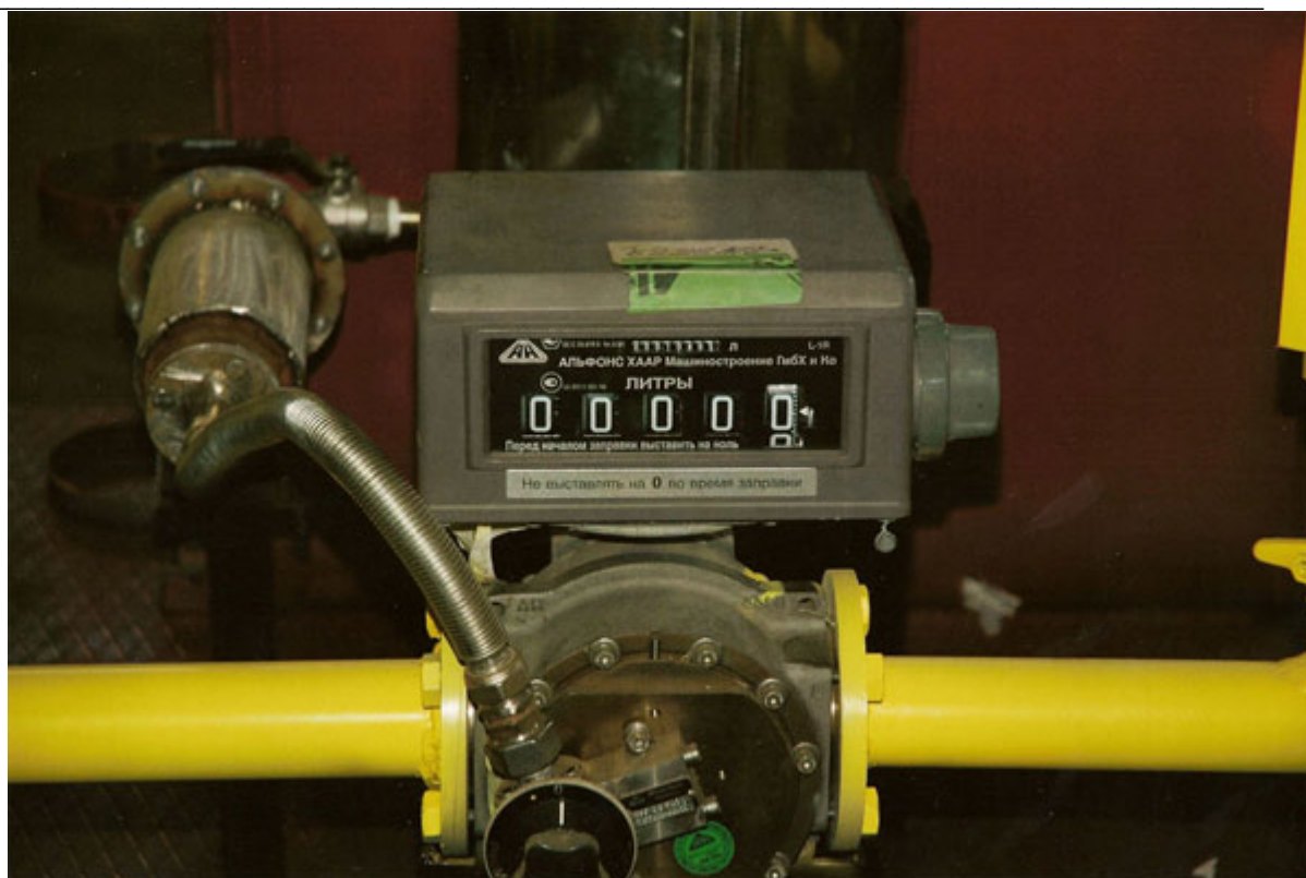
Рис.4. Счетчик с дозатором ПВК-жидкости МКА 800 В2 RDP1-MX1 MEZ-LV-1R производства «Alfons Haag», Германия.
